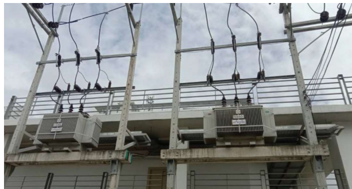
รูปที่ 2-23 การติดตั้งหม้อแปลงไฟฟ้าของโครงการ
