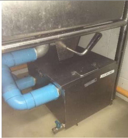
รูปที่ 2-12 การดูแลถังดักไขมัน
